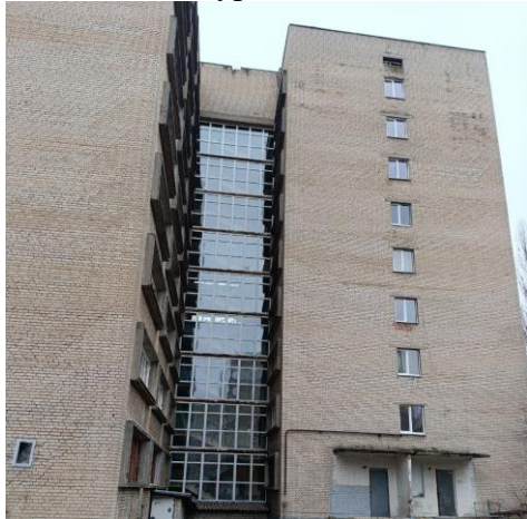
Скління фасаду в ЦПТО № 1.
