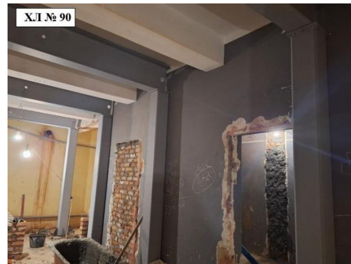
Будівництво ПРУ на базі ХЛ №90
